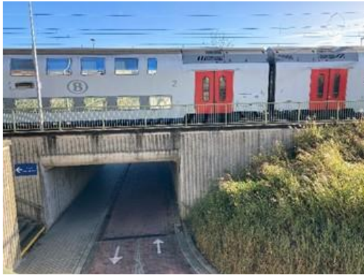
Figuur 19: Fiets-en voetgangerstunnel onder het station
