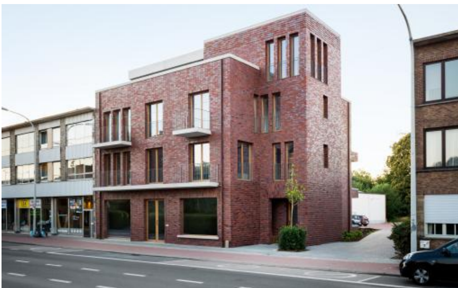
Hoekgebouwen in een bouwblok kunnen een zekere hoogte verdragen. Deze gebouwen zijn geschikt om op het gelijkvloers een publieke functie te plaatsen die aan de behoeftes van het bouwblok en de dichte omgeving voldoet.
