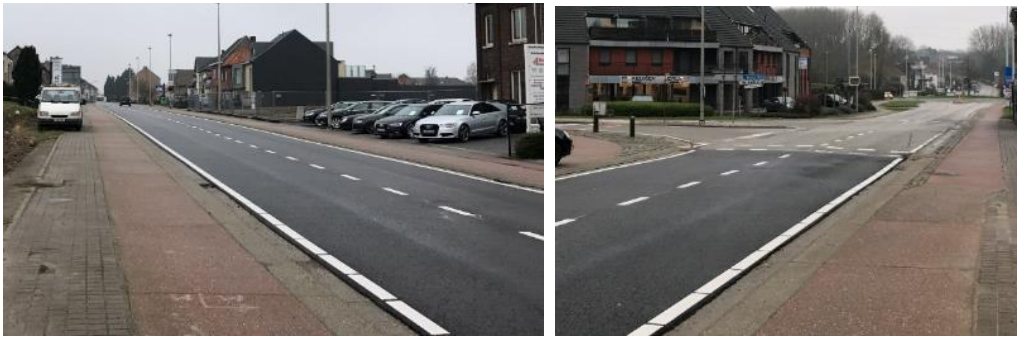
Figuur 3-9: N2 Maastrichterstraat (richting centrum Bilzen links - richting Maastricht rechts)
