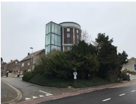
Foto 19 Zicht op watertoren
