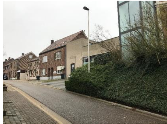
Foto 18 Zicht op watertoren in de Tabaartstraat
