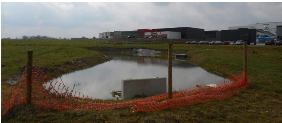
Foto 4 Bestaande waterbuffering ten zuiden van het plangebied.
