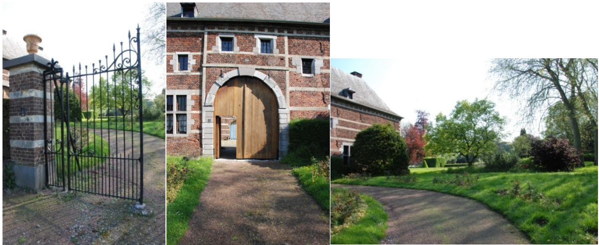
Poort en toegangspad van de Reekstraat naar de Zuidelijke vleugel van de Rentmeesterswoning
