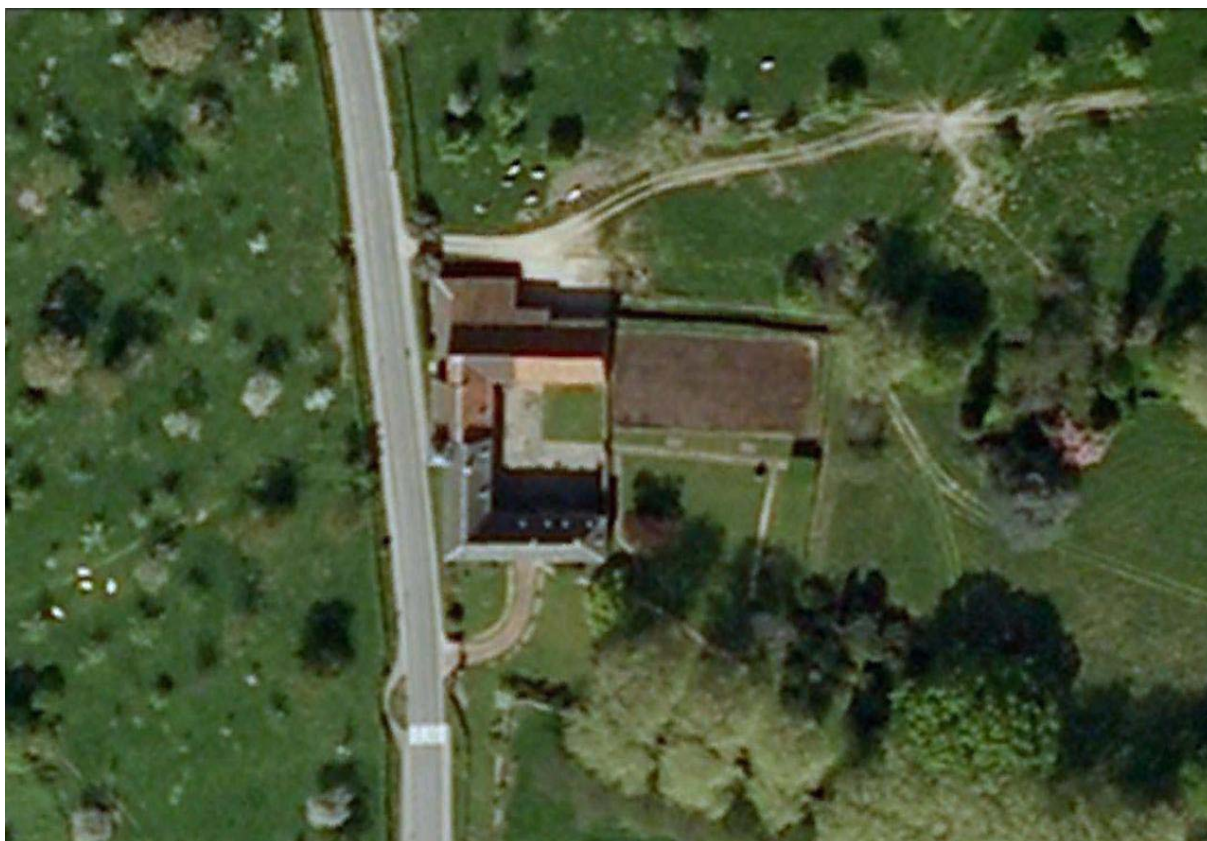
Luchtfoto van de Rentmeesterswoning
