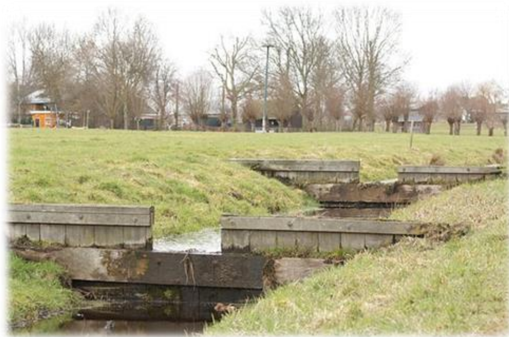
Figuur 7: schotten in grachten vermijden dat al het water wegstroomt en zorgen voor voldoende infiltratie.
